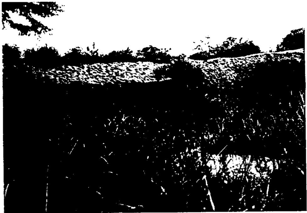
*Photo présentant au fond (en blanc) sous forme de colline, la digue de protection d'un périmètre refait en perré à l'issu de dégâts causés par une inondation.*
