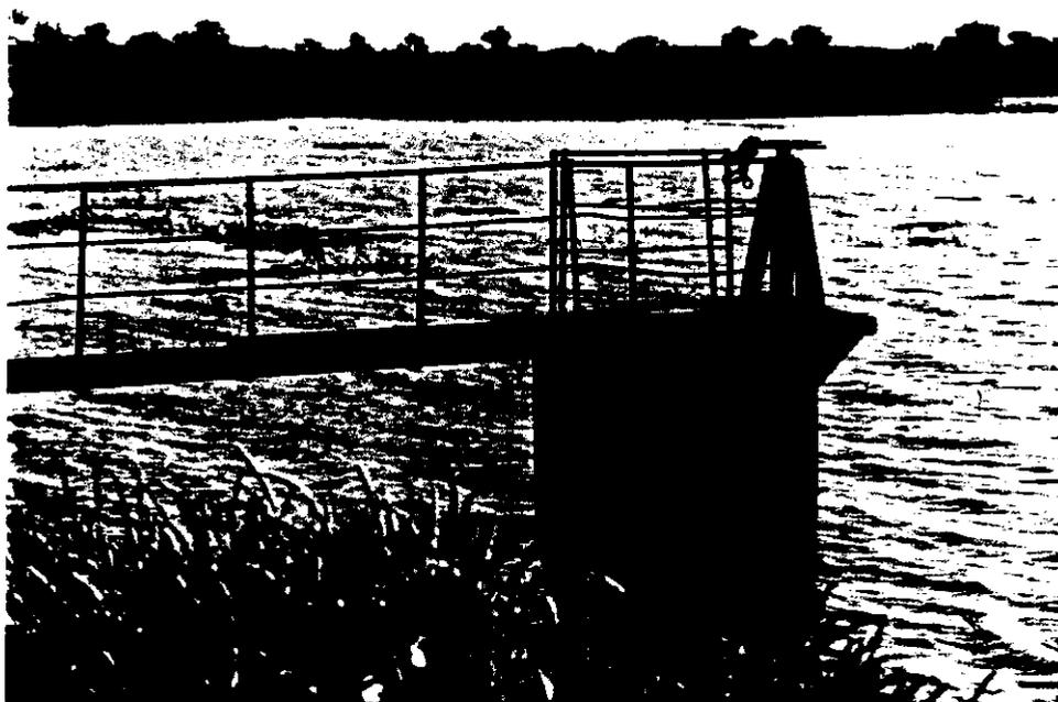
*Une prise d'eau en tour placée dans le barrage*
